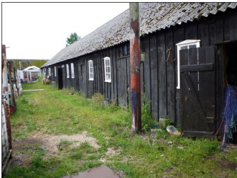
Lundeberg havn er oprindeligt ladeplads til Broholm og pakhuset er opført i tilknytning hertil.
