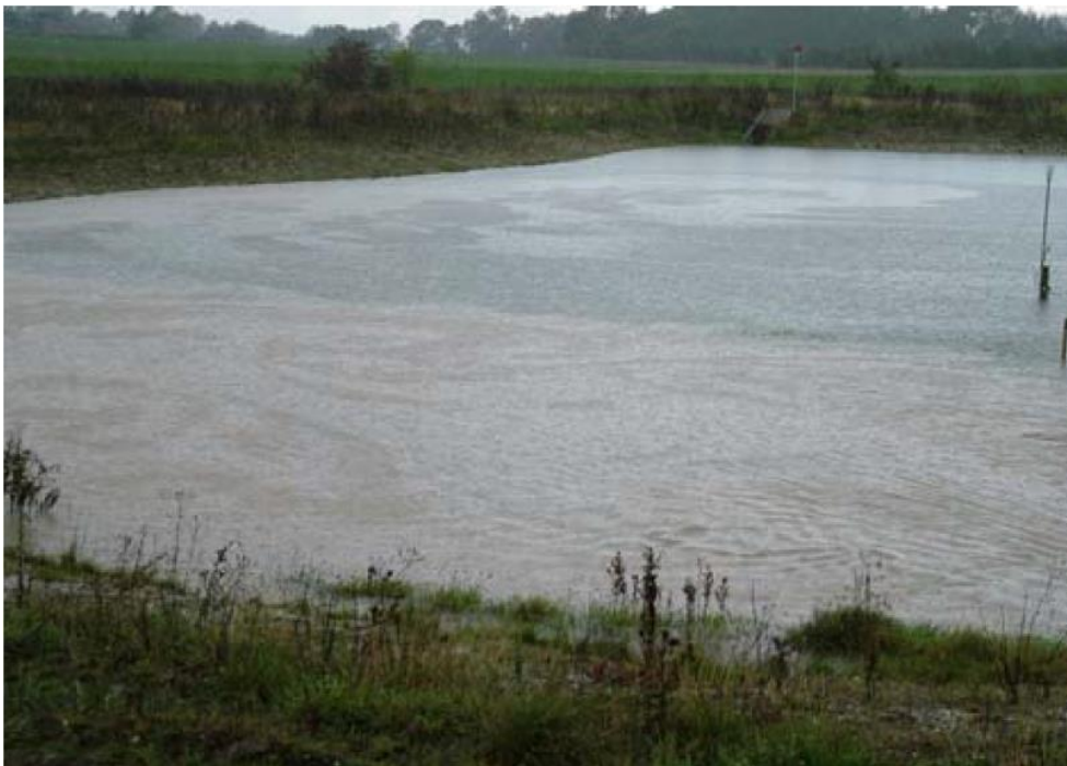
Figur 10: Regnvandsbassin hvor sandfang og resten af bassinet er adskilt af en bræmme. Bemærk at det mudrede indløbsvand bliver tilbageholdt bag ved bræmmen. Kilde: "Accumulation of pollutants in highway detention ponds", Thomas Ruby Bentzen, 2008.
