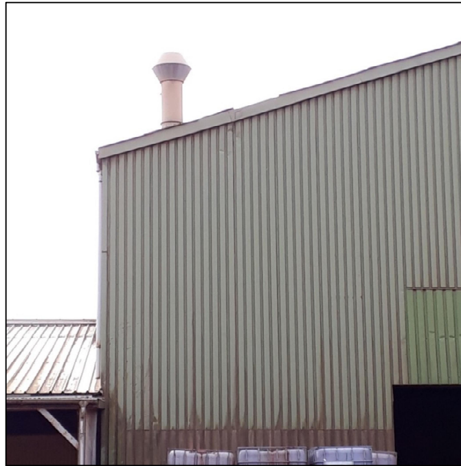
Billede 3. Kilde 101. Støj fra jethætten. Det er kilde 115 der ses nederst til højre samt på næste billede.
